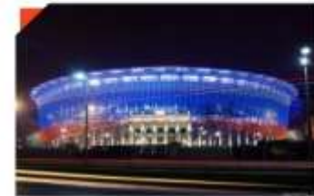
Реконструкция «Екатеринбург Арена», г. Екатеринбург
