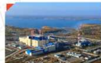
Белорусская АЭС, энергоблок №4 с реактором БН-800, г. Заречный
