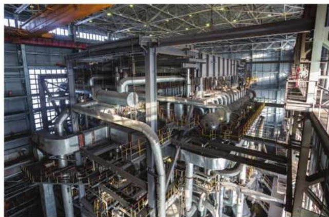
Филиал «Качканарская ТЭЦ» ОАО «ЕВРАЗ КГОК» г. Качканар. Техническое обслуживание, капитальный и текущий ремонт паровых котлов БКЗ-220-100Ф.
