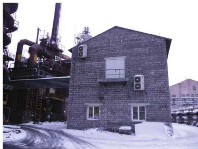
Здание пульта управления системой автоматизации доменной печи №5
