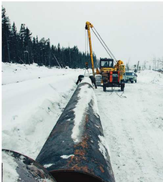
Шламохранилище ОАО «ЕВРАЗ КГОК» г. Качканар. Монтаж нового трубопровода Ø1000 мм для перекачки шлама.
