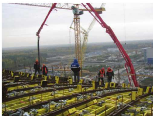
Бетонирование свода центрального зала БН-800
