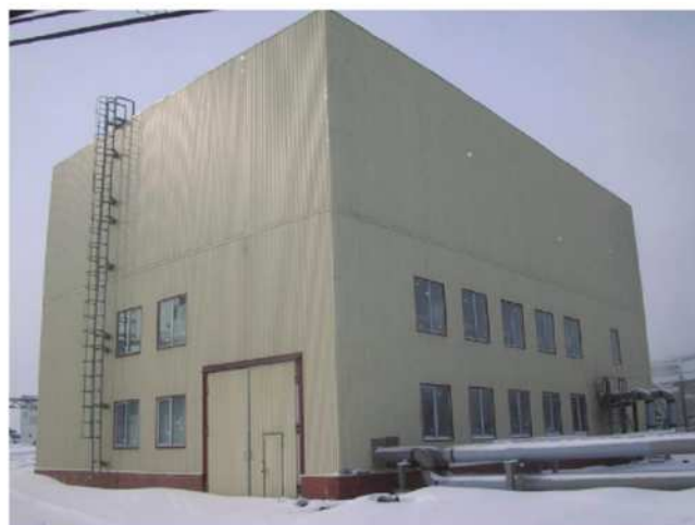
Здание блока очистных сооружений оборотного цикла водоснабжения газоочистки доменных печей на территории промышленной площадки завода
