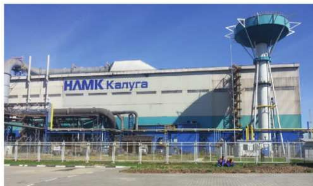
ООО «Новолипецкий металлургический комбинат» Калужская обл., Боровской р-н, с. Ворсино, ул. Лыскина, 20 Антикоррозионная защита металлоконструкций. Окраска железобетонных конструкций. Кладка кислотоупорного кирпича и плитки. Окраска технологического оборудования. Монтаж/демонтаж стенового и кровельного ограждения из сэндвич-панелей и профлиста. Все работы выполнялись с лесов и методом промышленного альпинизма.
