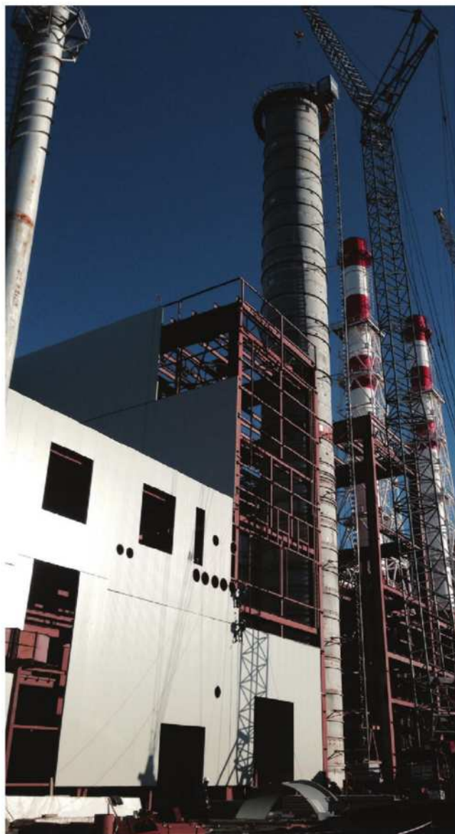
Дымовая труба, котельное отделение, главный корпус. Нижнетуринская ГРЭС.
