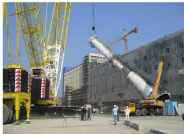
Монтаж вентиляционной трубы Спецкорпуса БН-800
