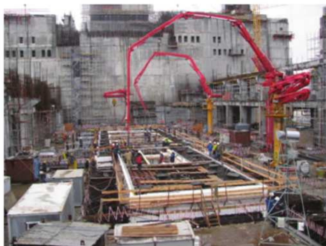
Бетонирование фундамента турбоагрегата БН-800
