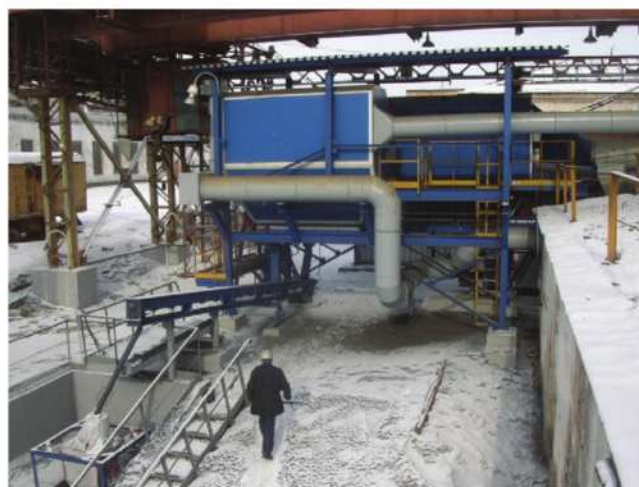
Аспирационная установка участка чугунолитейного цеха с двумя рукавными фильтрами КФЕ192А6 и КФЕ384А6 на промышленной площадке литейного цеха
