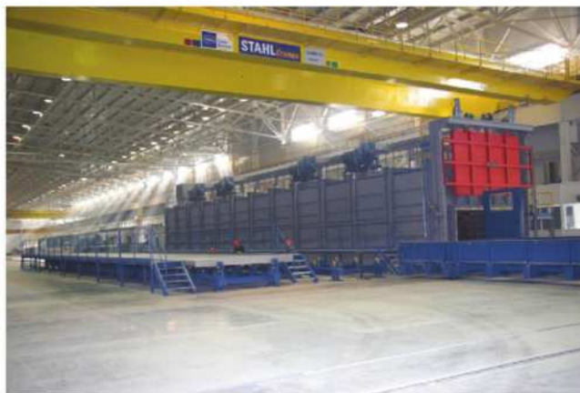
Корпус для производства крупногабаритных плит
