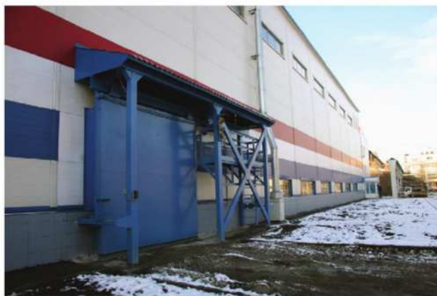
Корпус для производства крупногабаритных плит
