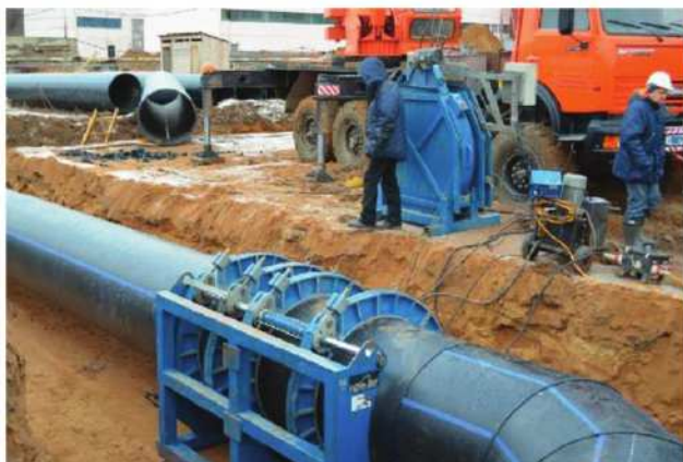
Площадка ФГУП «Комбинат «Электрохимприбор» г. Лесной. Монтаж труб полиэтиленовых Ø1000 мм системы водоснабжения.
