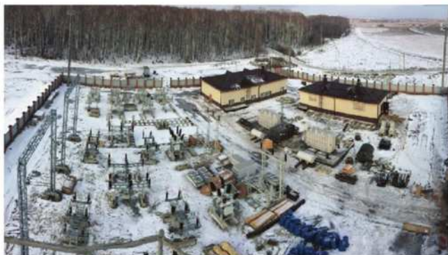
Проект «Строительство ПС 1103510 кВ Zubovo, Уфимский район, ПО УГЭС
