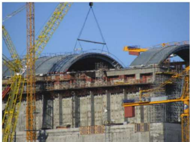
Монтаж металлоконструкций (несъемной опалубки) свода центрального зала БН-800
