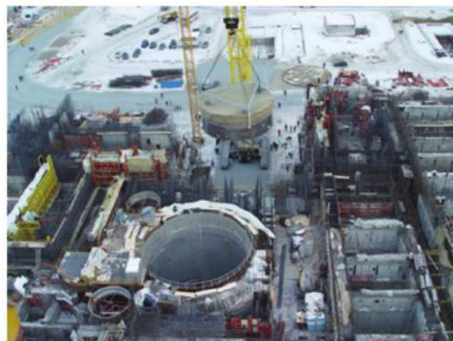
Монтаж корпуса реактора БН-800
